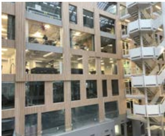
K6, Malmö. Renovering av kontorshus åt Svenska Hus.
