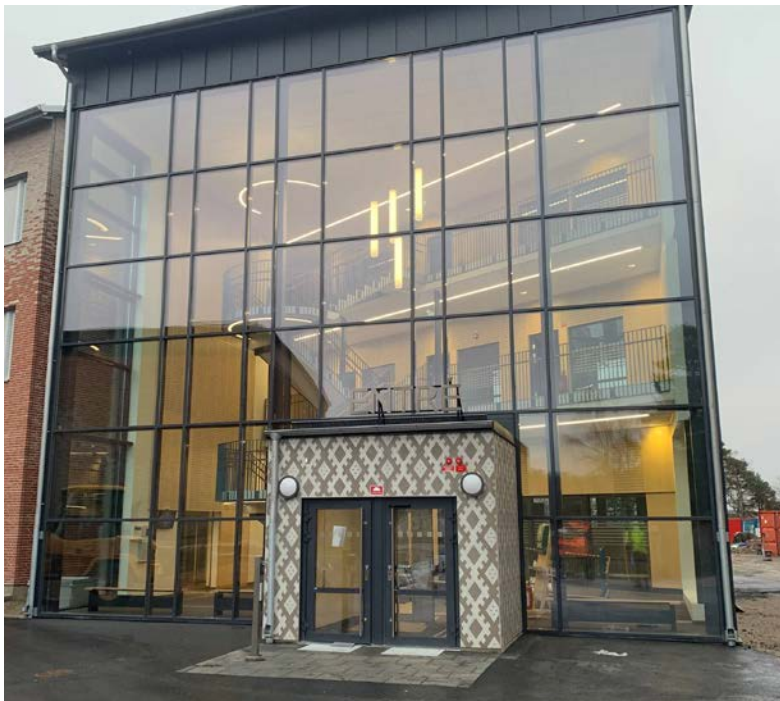
Ramnerödsskolan, Uddevalla. Om- och nybyggnad av F-9 skola. Beställare: Uddevalla kommun.
