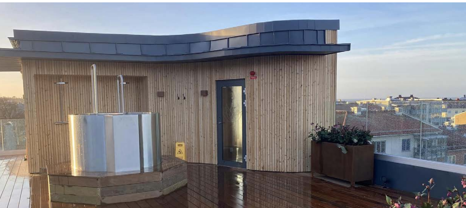
Varbergs Stadshotell & Asia Spa. Tillbyggnad av takterrass med bastu och utomhuspool. Beställare: Varbergs Fastigheter.
