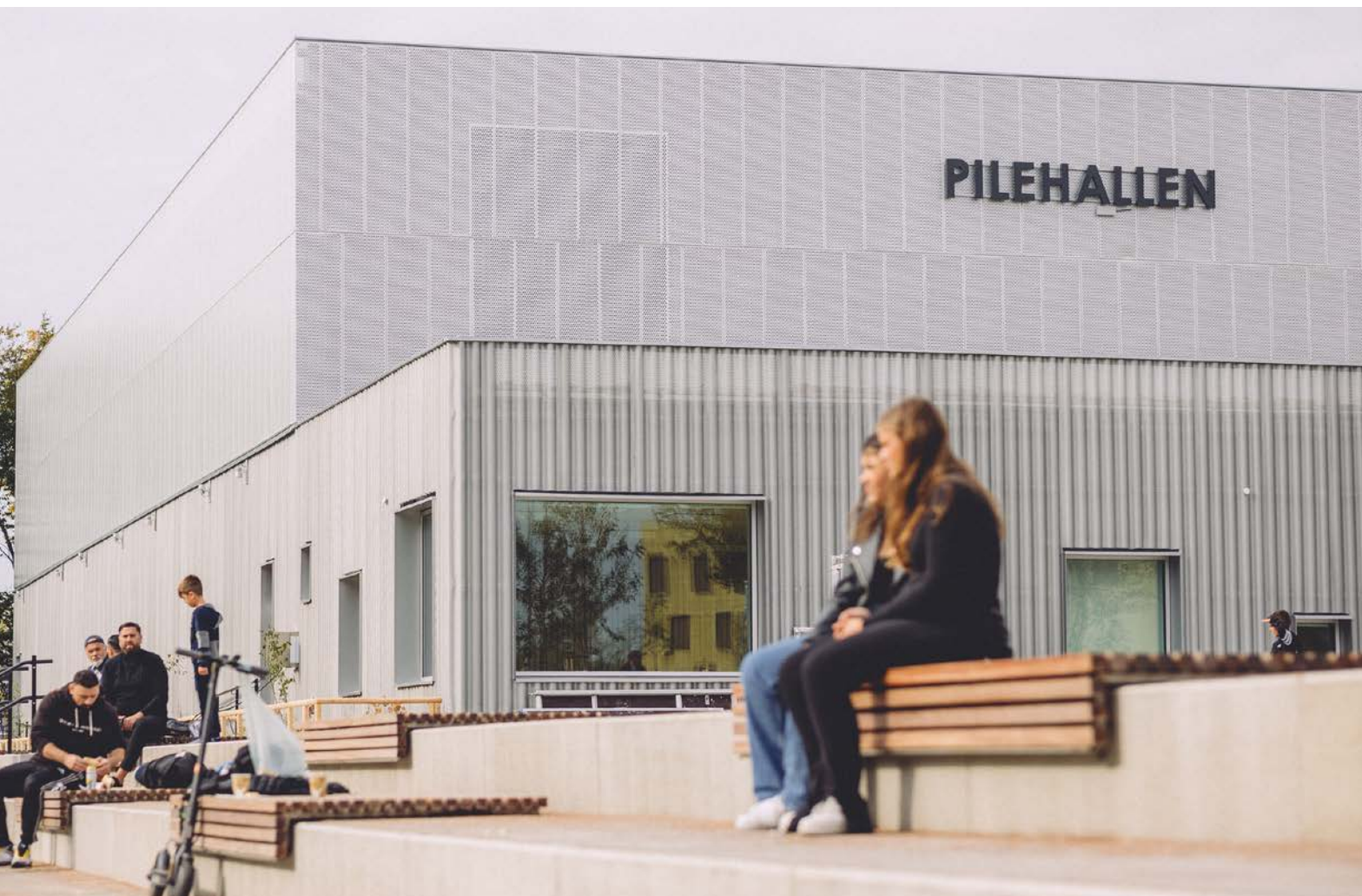
Pilehallen, Trelleborg. Nyproduktion av idrottsanläggning med två hallar och fritidsgård. Beställare: Hemsö Fastighets AB.
