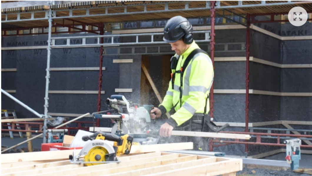
Det första huset får nu sina ytterväggar, och här kapar Konrad Boström så kallad läkt. Det är brädor som ska hålla fast ytterpanelen. Foto: Yvonne Rönngren
